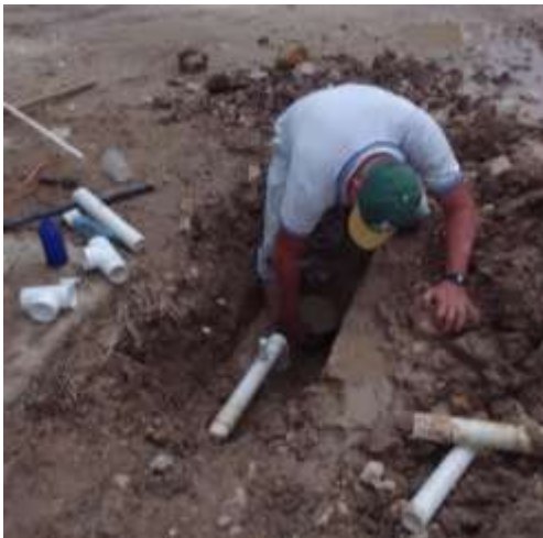
Reparando tubería tapada en barrio Santa Elena.
