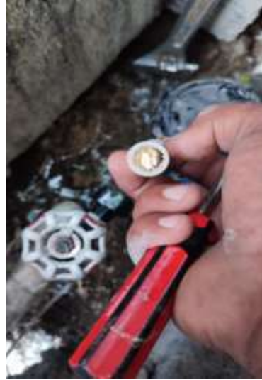
Enterando zanja donde se revisó tubería que se encontraba tapada en barrio el centro.
