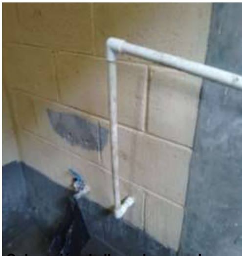
Colocación de llave de paso de corona de bronce en barrio campito.
