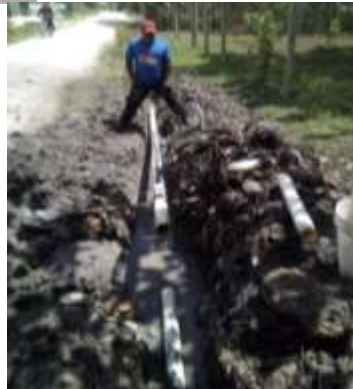
Reparando tubería en barrio plancha de piedra.
