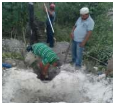
Instalando servicio en barrio el porvenir.
