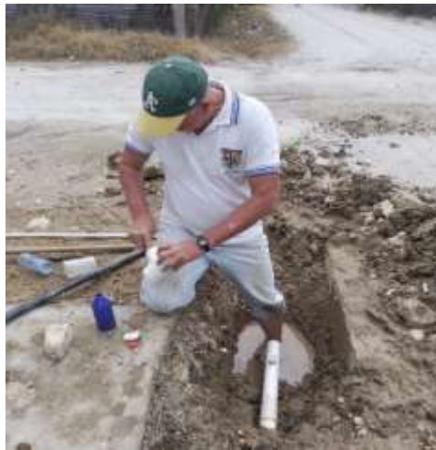
Reparando tubería tapada en barrio Santa Elena.
