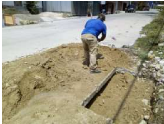
Enterando zanja donde se revisó tubería que se encontraba tapada en barrio el centro.
