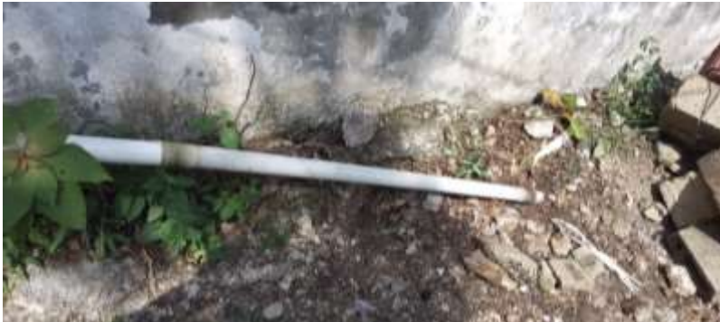
Reparación de tubería en barrio fallabón.
